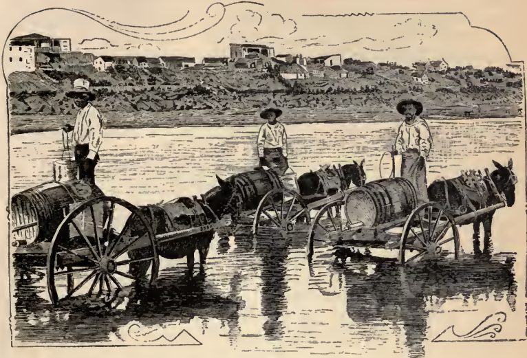
OBRAS HIDRAULICAS—Nuevo Laredo, Mexico. [Ferrocarril Nacional Mexicano.]
